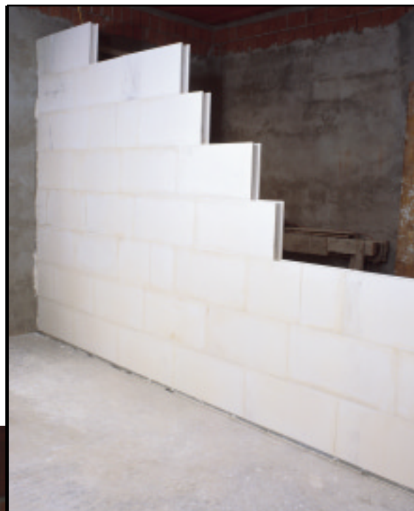
Parete in costruzione con blocchi in gesso Carraro.
